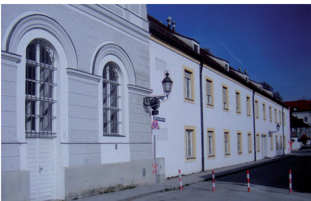
Derzeitige Situation mit dem ehemaligen Institutsgebäude
